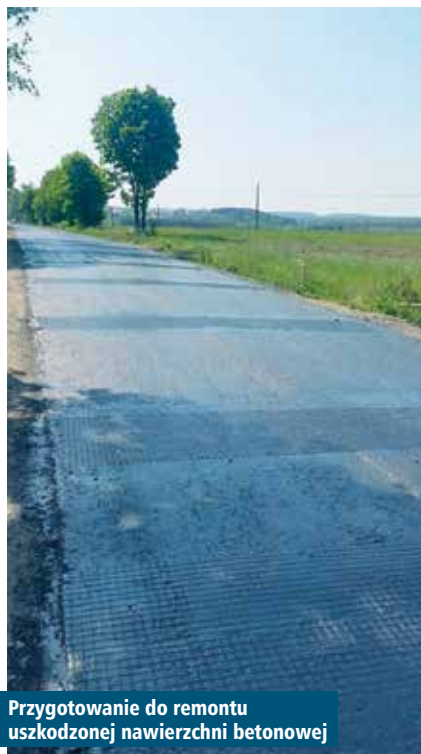
Wbudowana nawierzchnia jednowarstwowa na drodze betonowej
