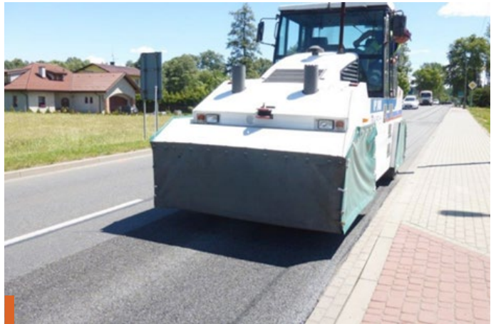
Proces wałowania PU walcem ogumionym
