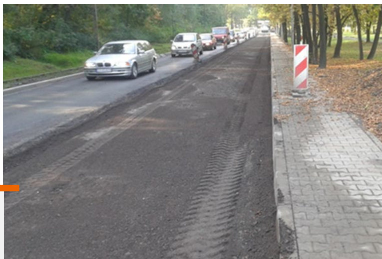
Kruszywo doziarniające po rozłożeniu – wykonanie MCE „in situ”
