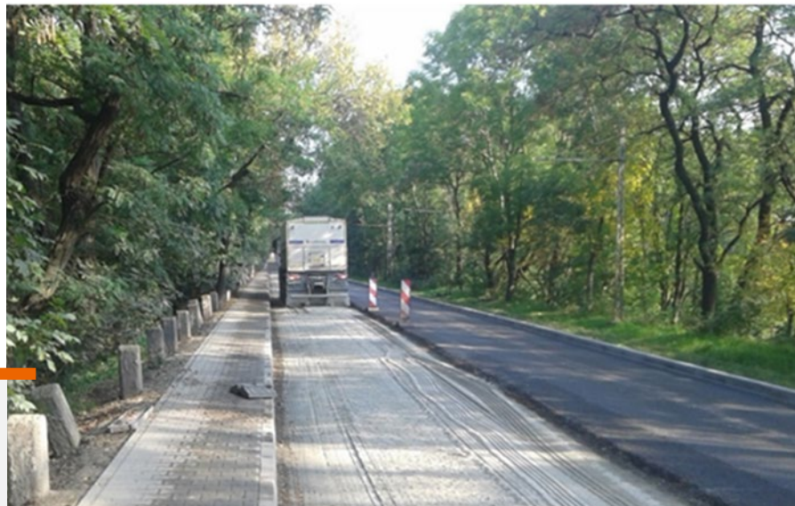
Proces rozsypywania cementu – wykonanie MCE „in situ”
